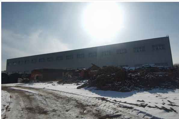
二号风井接力泵站南侧现状
