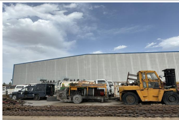
二号风井接力泵站南侧现状
