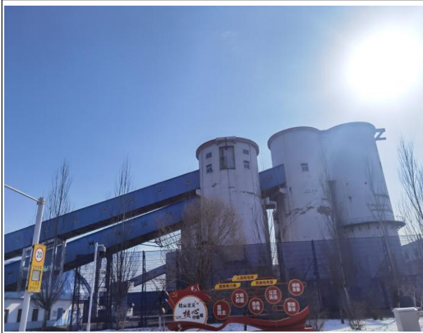
煤矿现有矸石仓
