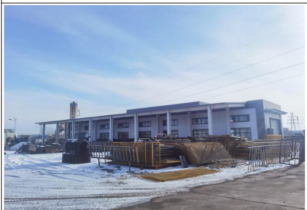
南侧现状（公司现有库房）
