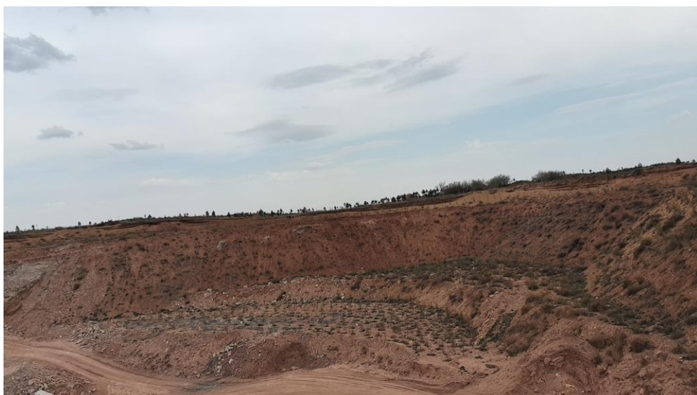
照片 2-3 历史采坑回填效果（镜像 NE）
