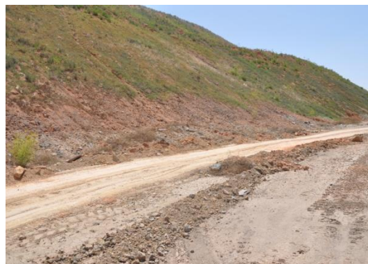
照片 1-4 进场道路（镜向 NE）
