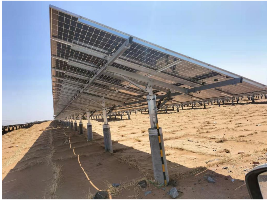
图 2-2 光伏支架及基础设计示意图
