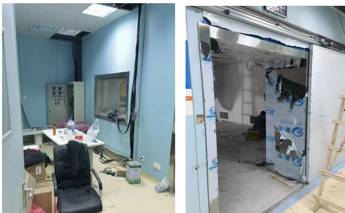
现场施工装修时的现场照片
