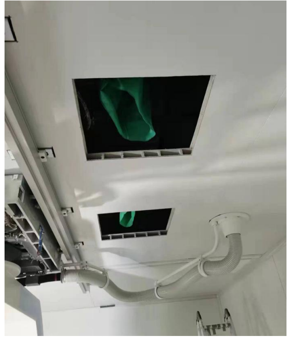
DSA 导管室内顶部装修现场照片
