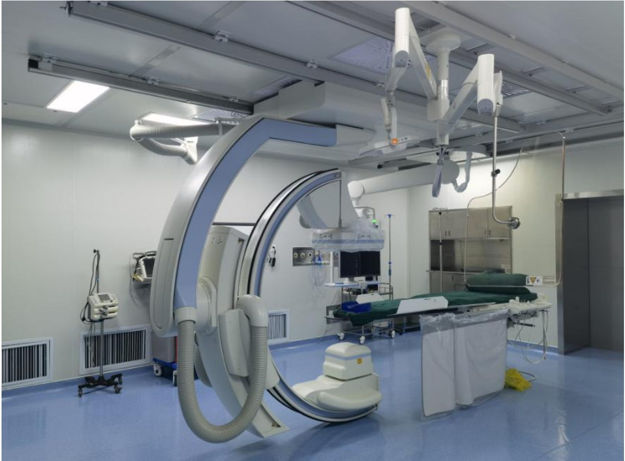
施工完毕后现场照片
