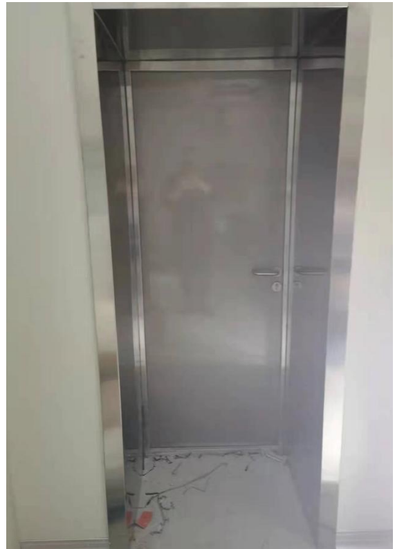
DSA 导管室南侧污物通道防护门现场照片
