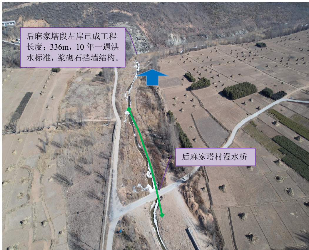
图 3-3 后麻家塔村漫水桥位置河道现状
