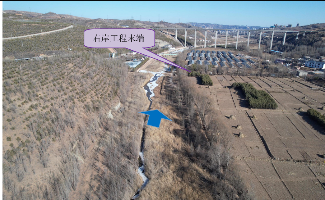
图 3-4 工程末端位置河道现状
