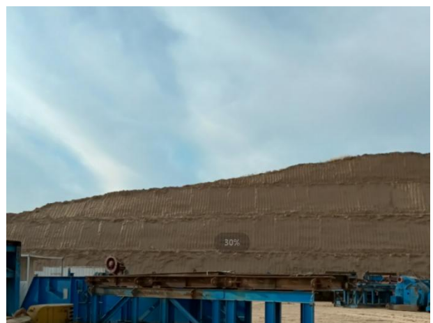
厂区西侧现状
