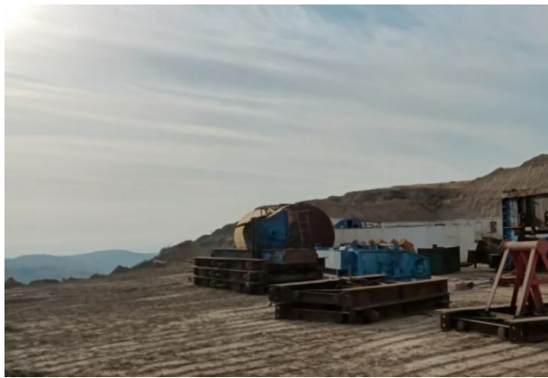
项目南侧现状
