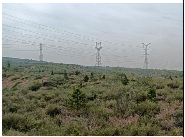
厂区西侧现状
