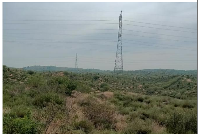
厂区东侧现状
